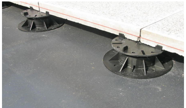
Abb. 24: PLV50/75, Beginn einer Plattenverlegung am Rand mittels Lotfaden.
